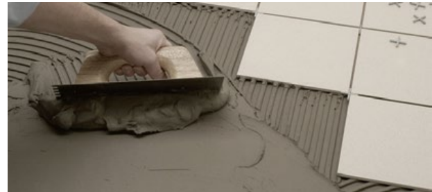
Aplicación del adhesivo. Adhesive material application.
