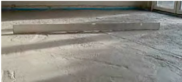
Preparación del soporte. Preparing the support.
